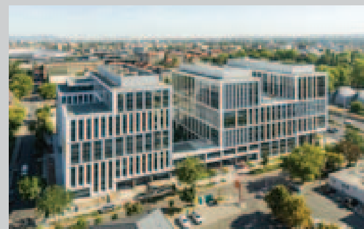
Aréna Business Campus A Épület, Budapest
